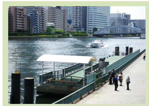
隅田川にある防災船着場 (都建設局提供)
