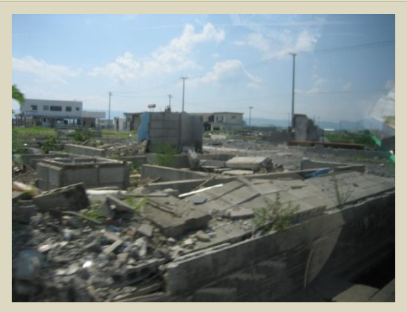
復旧が進まない相馬市の沿岸部
